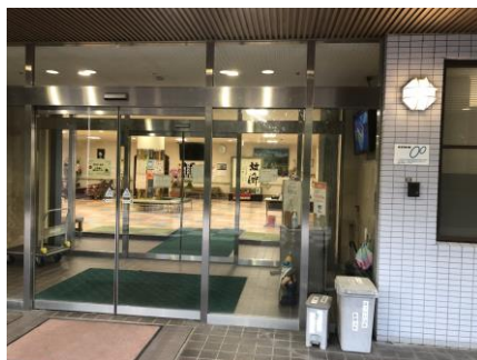
施設正面玄関の写真
